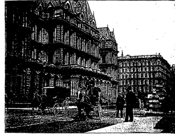
CHICAGO. — Post Office, dans Jackson Street.
